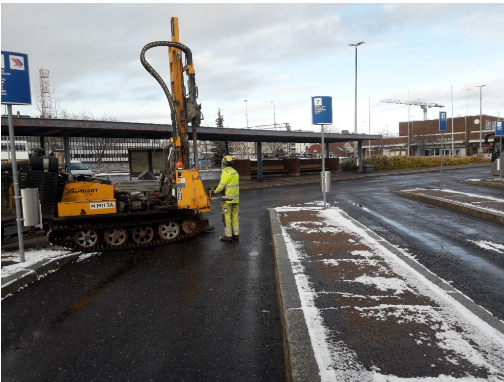
Kuva 2. Kairausta linja-autoaseman laitureiden välissä.
