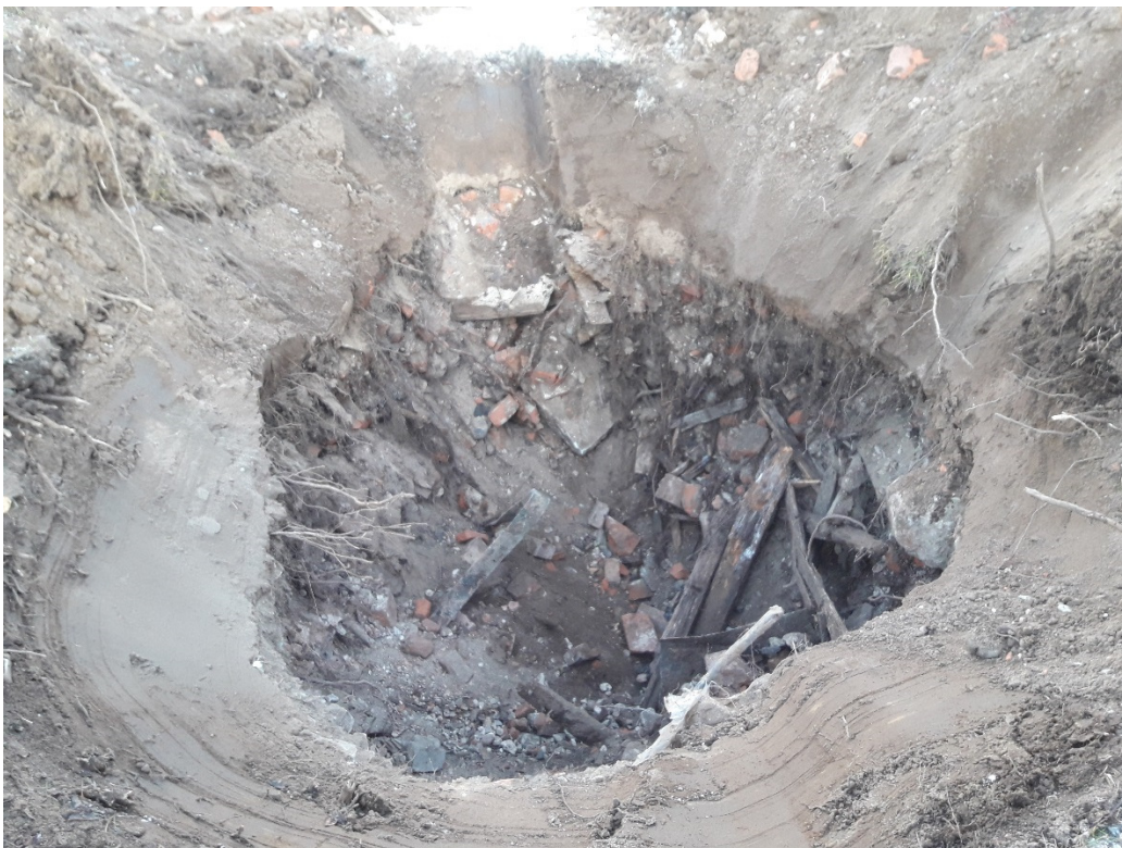
Kuva 4. Täyttömaakerroksen jäte sisälsi mm. puuta, tiiltä ja betonia.
